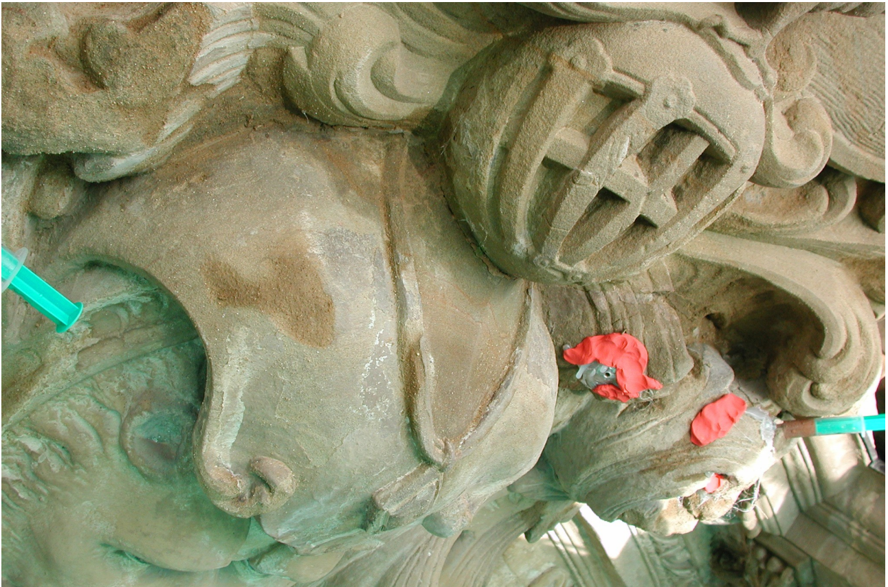
Abb. 5: Abgeschlossene Rissverschließung
