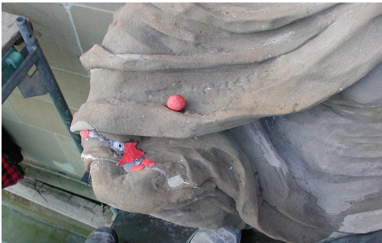
Abb. 7: Rissinjektion an der linken Gesimsfigur des Nordportals
