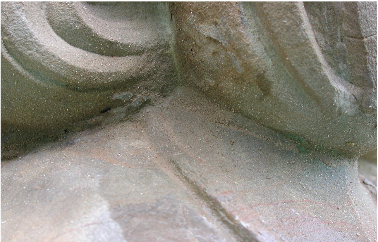
Abb. 5: Abgeschlossene Rissverschließung
