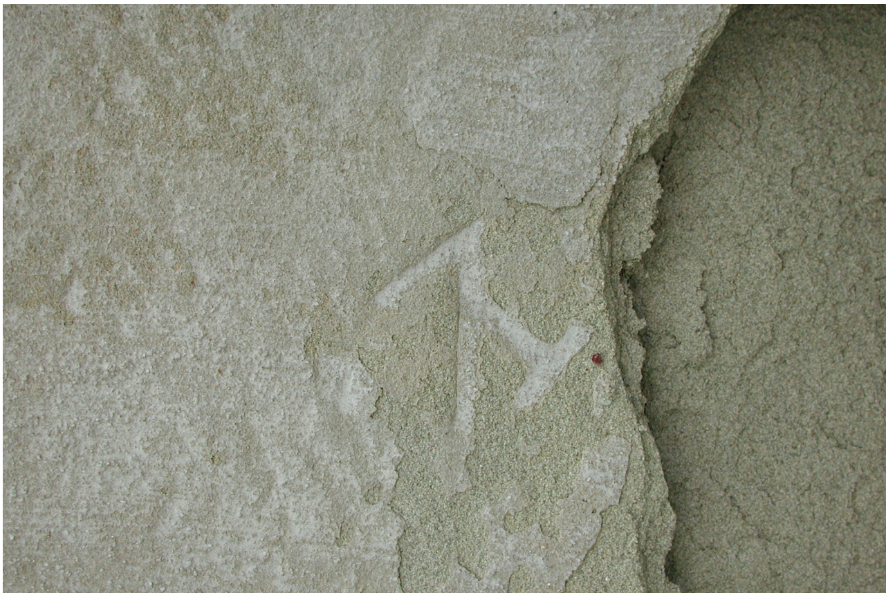
Abb. 4: Ausarbeiten und antragen von Steinersatzmörtel an einem Fenstersturz
