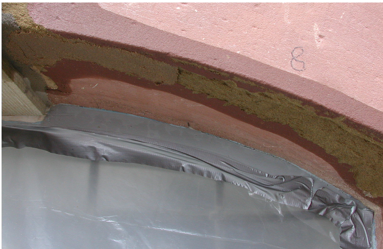
Abb. 4: Ausarbeiten und antragen von Steinersatzmörtel an einem Fenstersturz
