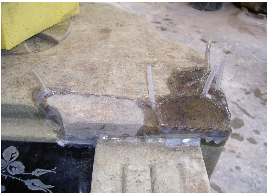
Abb. 10: Sicherung von Einzelteilen, Hinterfüllung nach punktuelltem Kleben
