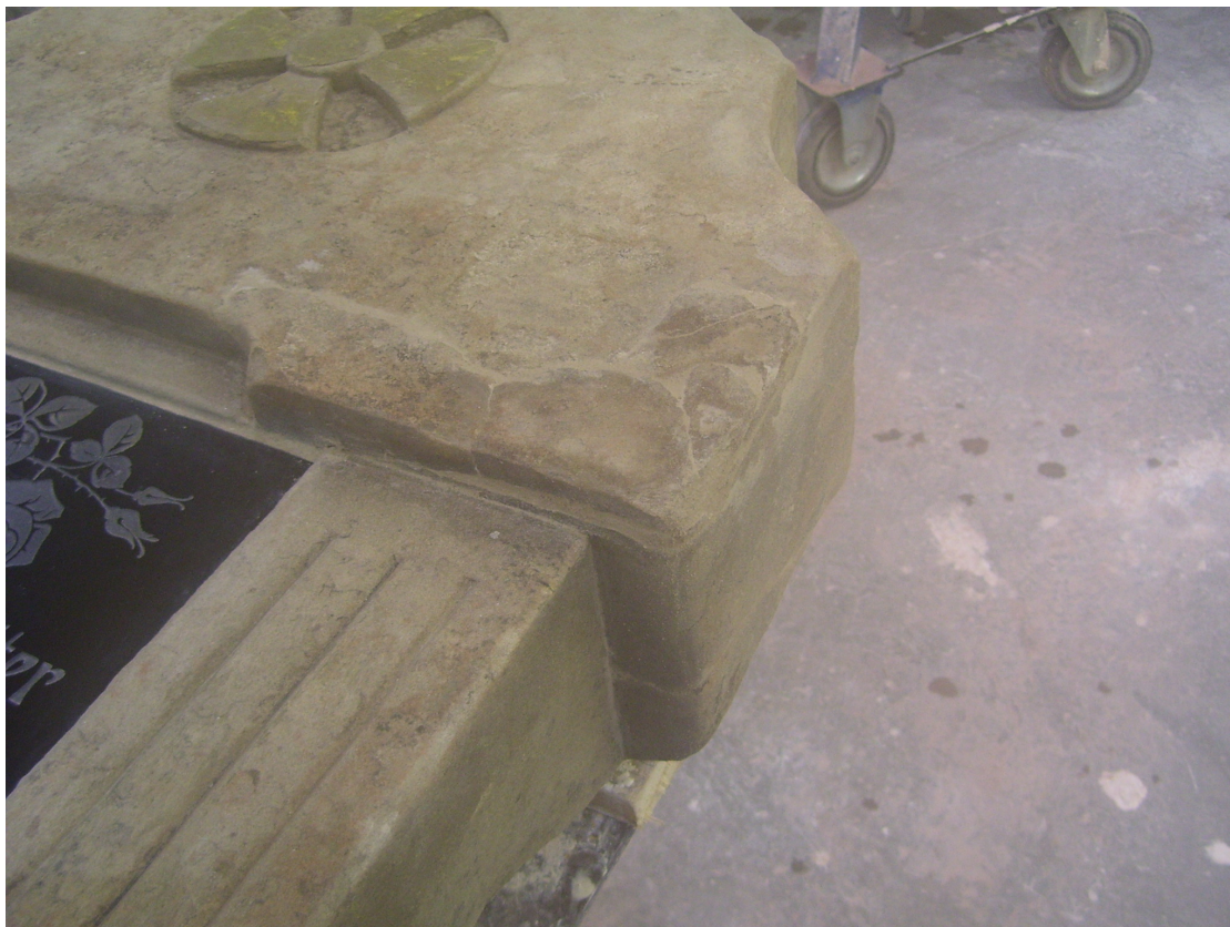
Abb. 14: Sicherung gefährdeter Teile
