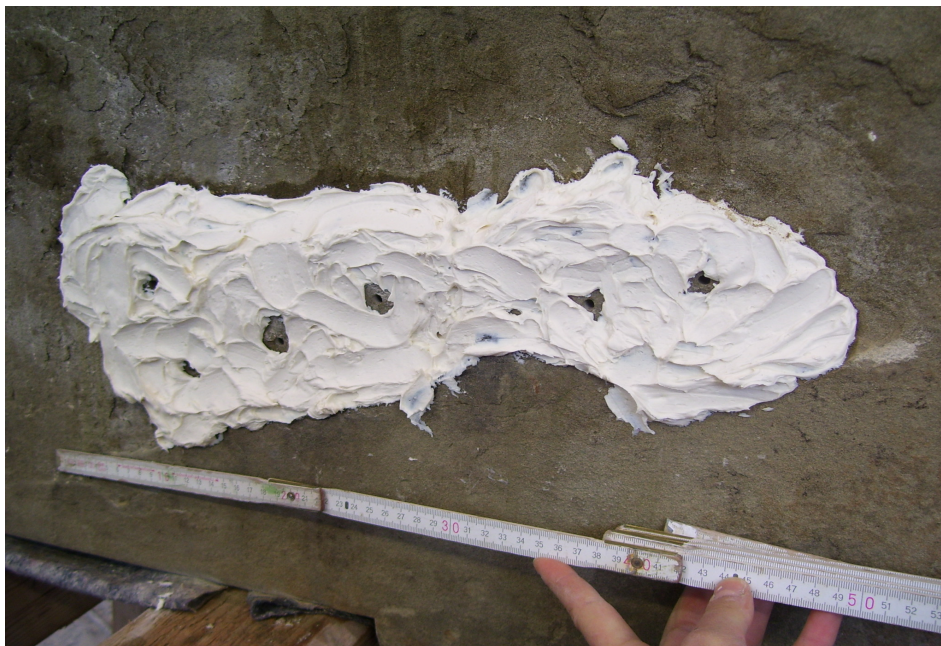
Abb. 10: Sicherung von Einzelteilen, Hinterfüllung nach punktuelltem Kleben
