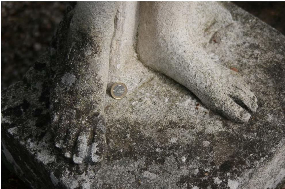
**Abb. 7:** Detail am Sockel: *Verwitterungsformengruppe Gesteinsanlagerungen: Ansiedlungen durch Mikroorganismen*
