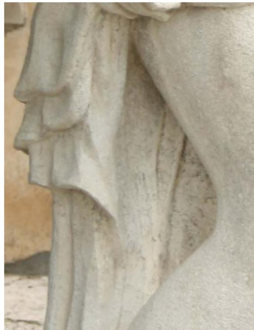
**Abb. 18 + 19:** *Behandlung der dunklen kongruenten Kruste mit Ammoniumbicarbonatkomresse und anschliessend mit Bakterien in Carbogel und Clucel.*
