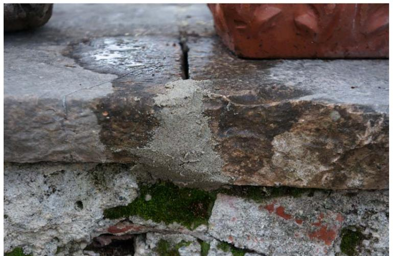
**Abb. 27+28:** Kleben und Antragung mit Kalk-Kaseinmörtel
