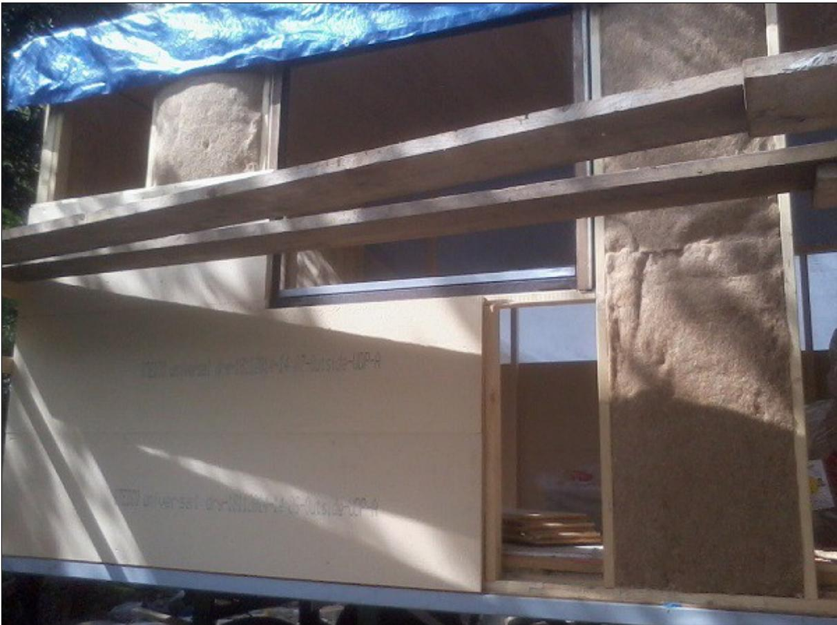
**Schritt 16:** Holfaserwände annageln, Dachlatten ranschrauben, Wände dämmen, französische Kieferplatten einsetzen.
