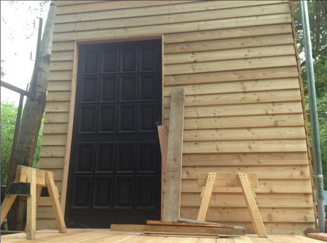
**Schritt 23:** Regenrinne mit Gefälle und Fallrohr anbringen.
