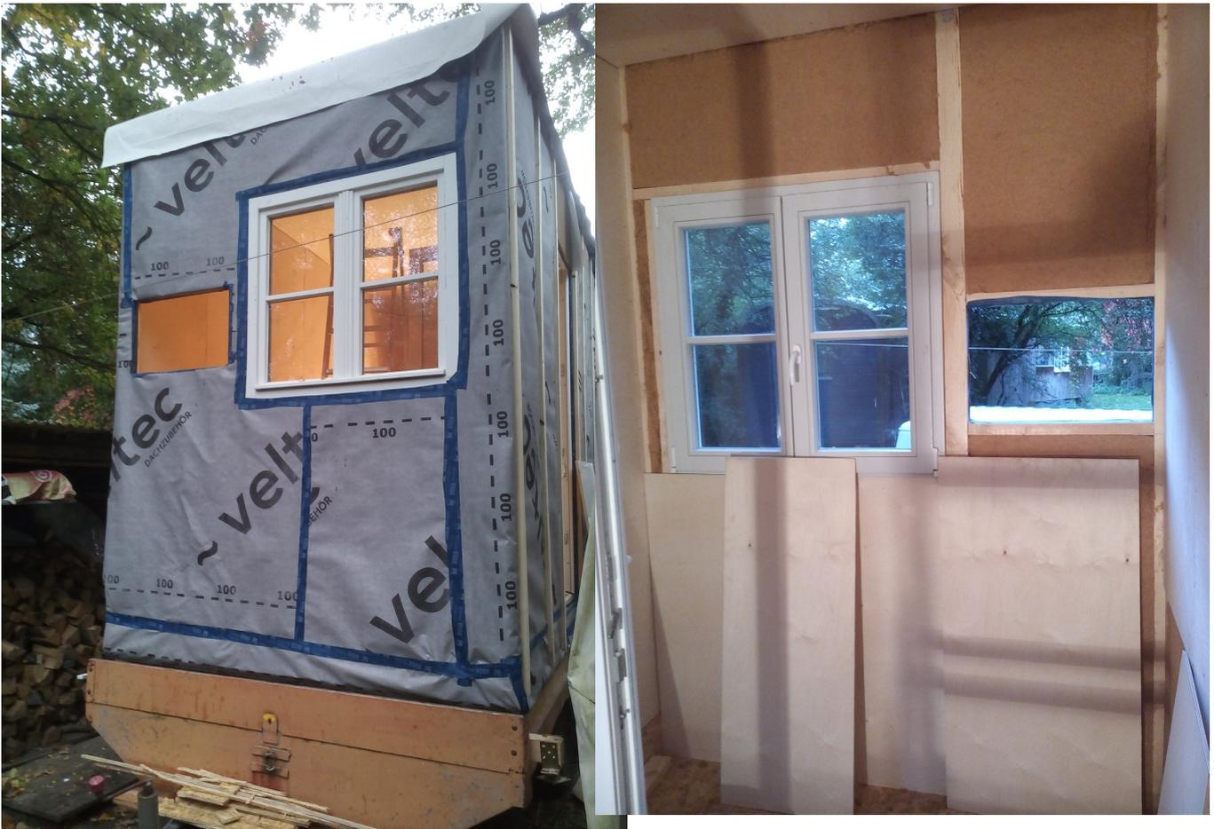
**Schritt 11:** Holfasermatten mit Holzfaserplatten an Seitenwände annageln, die mit restlichen Scheiben durch die Innenwände versehen wurden, Windschutzfolie drüber (antackern, miteinander mit Folienklebeband verbinden), Dachlatten befestigen.
