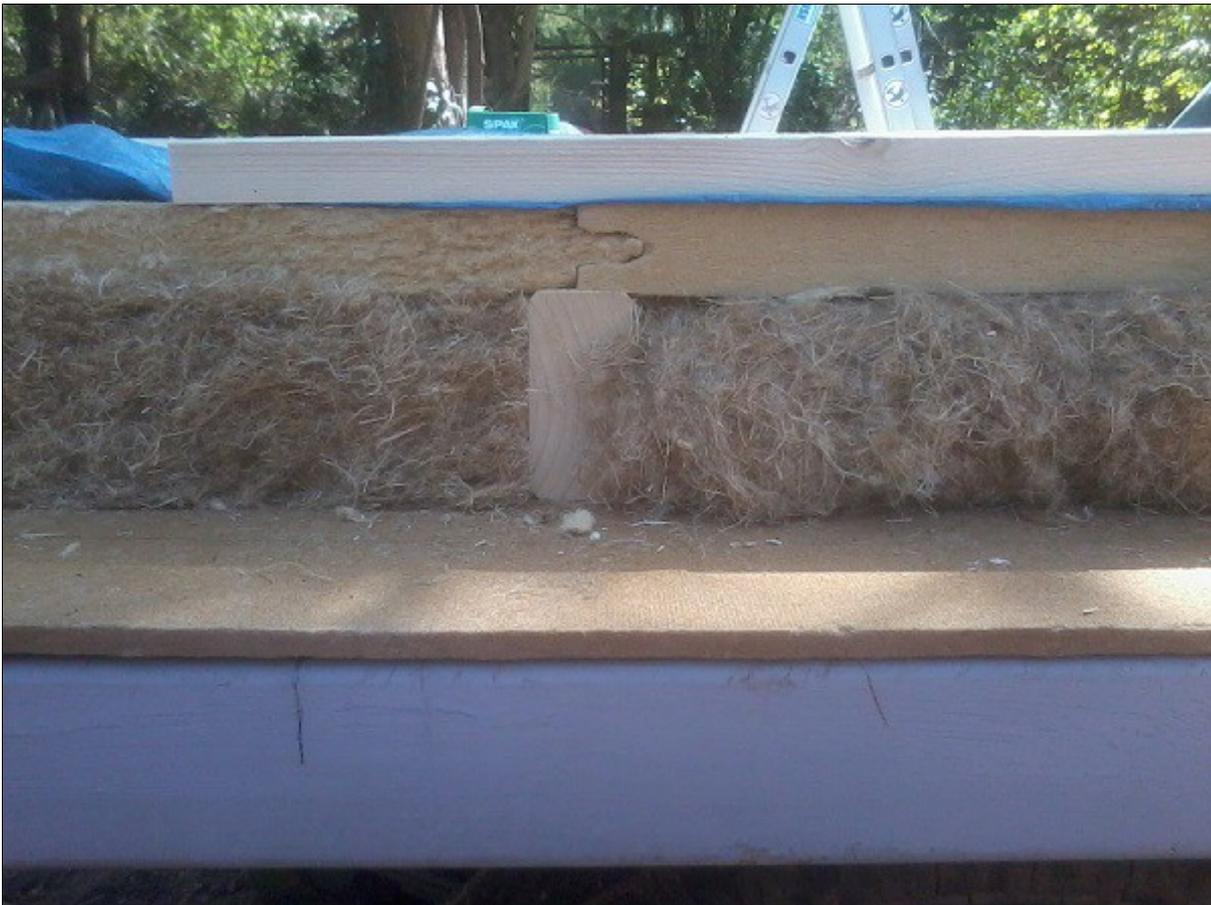
**Schritt 6:** Boden soweit aufbauen wie möglich: Dünne Holzfaserplatte, KVH Deckenbalken (Festschrauben von Oben und unten), Dämmung zurechtschneiden mit Dämmmesser, dicke Holzfaserplatte (nageln), Plane zum Schutz (mit Dachlatten kurzzeitig befestigen).
