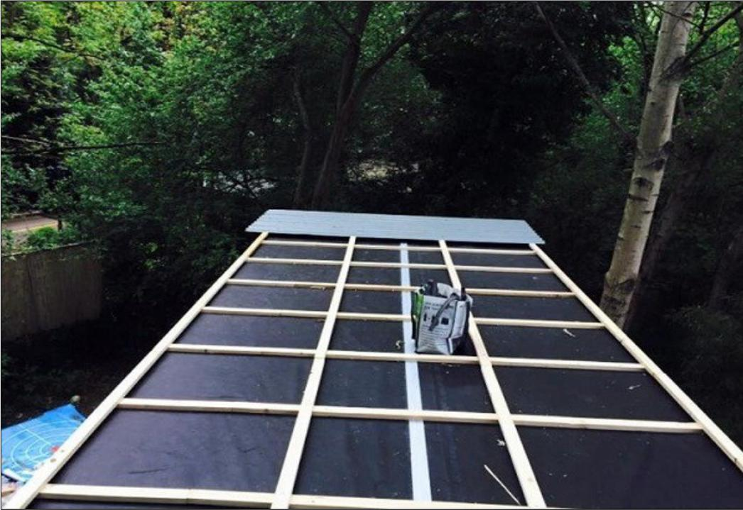
**Schritt 18:** Diffusionsoffene Folie auf das Dach tackern, Dachlatten und Trapezblech ranschrauben. Ggf Ungezieferschutznetz seitlich antackern.
