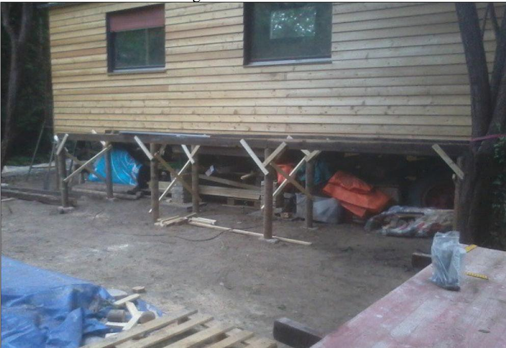
**Schritt 25:** Terrassenkonstruktion bauen. Schutz vor aufsteigende Feuchte durch Ziegelsteine als Fundament. Genug Abstand vor Fassade halten (aufgrund Spritzwasser).
