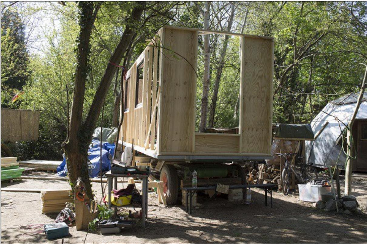
**Schritt 10:** Kurzzeitige Verschwertung mit Dachlatten, damit die Konstruktion sich nicht verzieht (Diagonale pro Fach ausmessen, so dass diese die gleiche Maße ausweisen).
