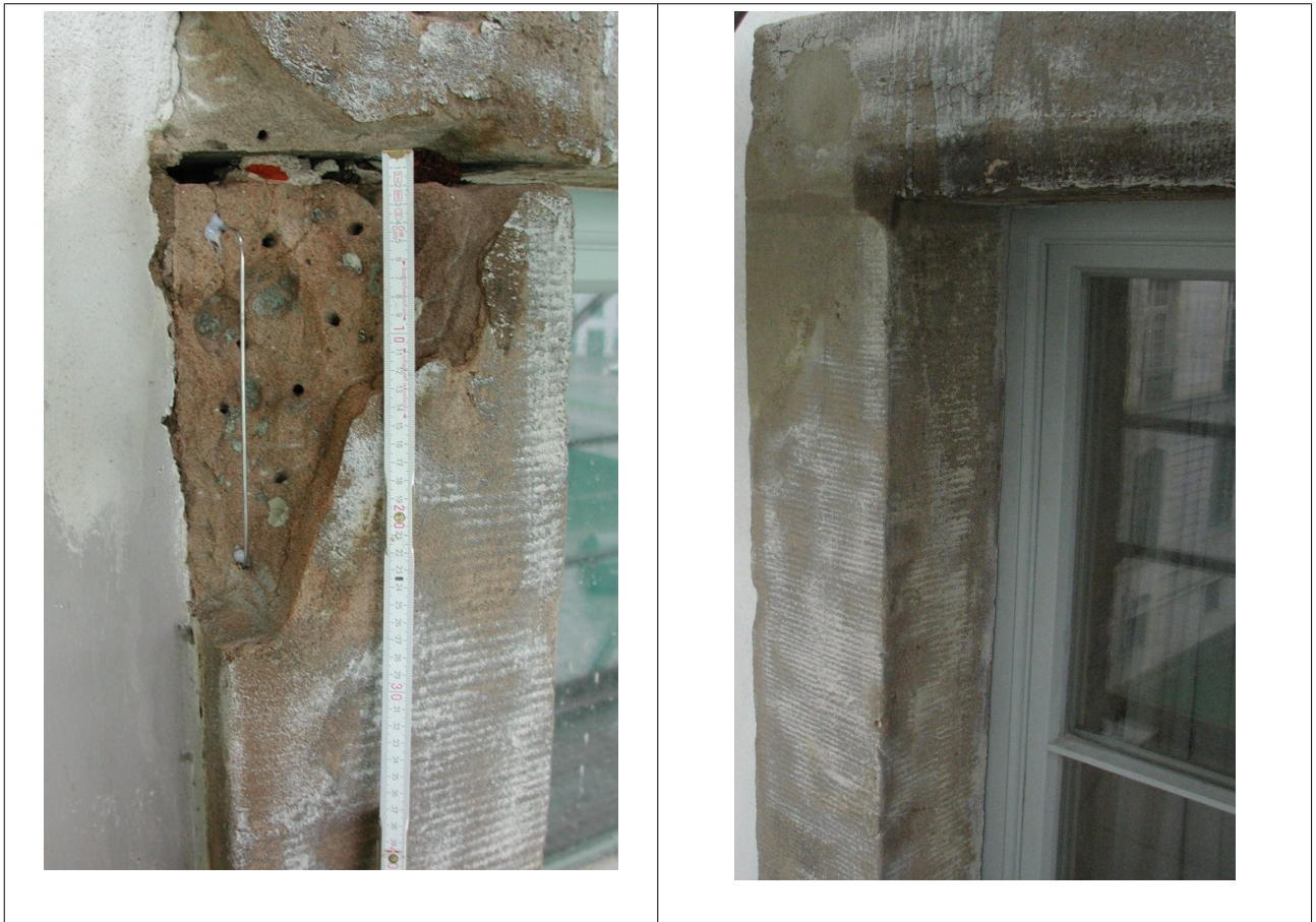
Abb. 5: Ausarbeiten und armieren von Antrageflächen an einem Fenstergewände
