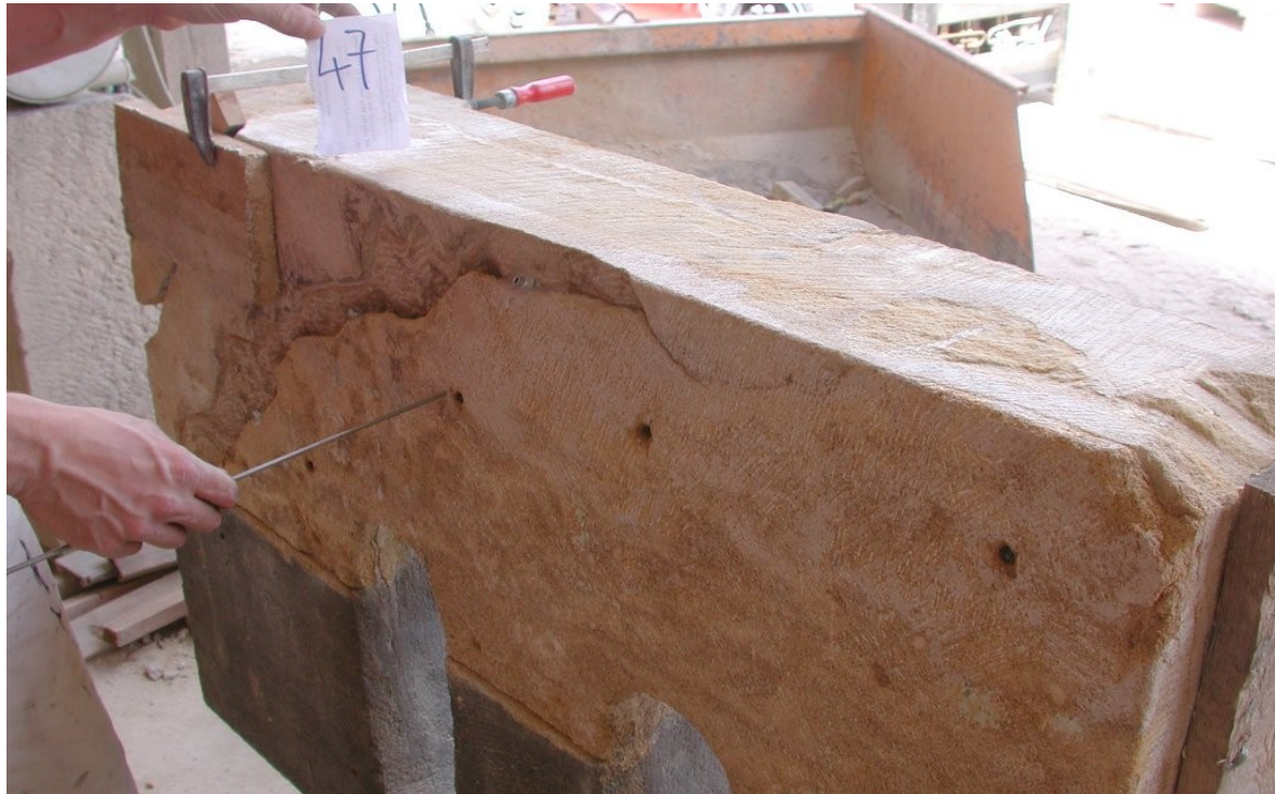
Abb. 8: Verdübeln, versetzen von Bruchstücken
