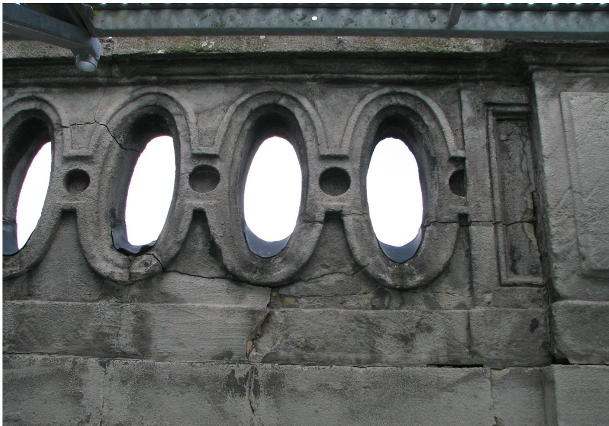
Abb. 1: Steinschäden an Sockel, Brüstungsfeld mit Durchbrüchen, und Abdeckern
