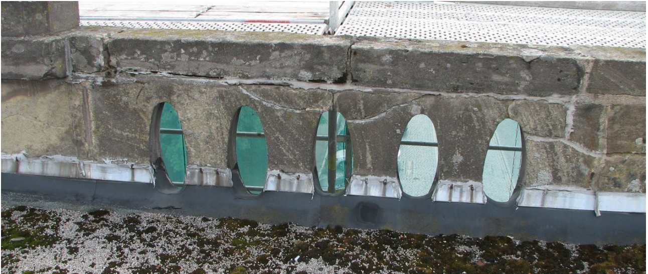
Abb. 4: Lösen der Gummilippen, öffnen der Fugen und nummerieren der Positionen vor Abnahme der Abdecker
