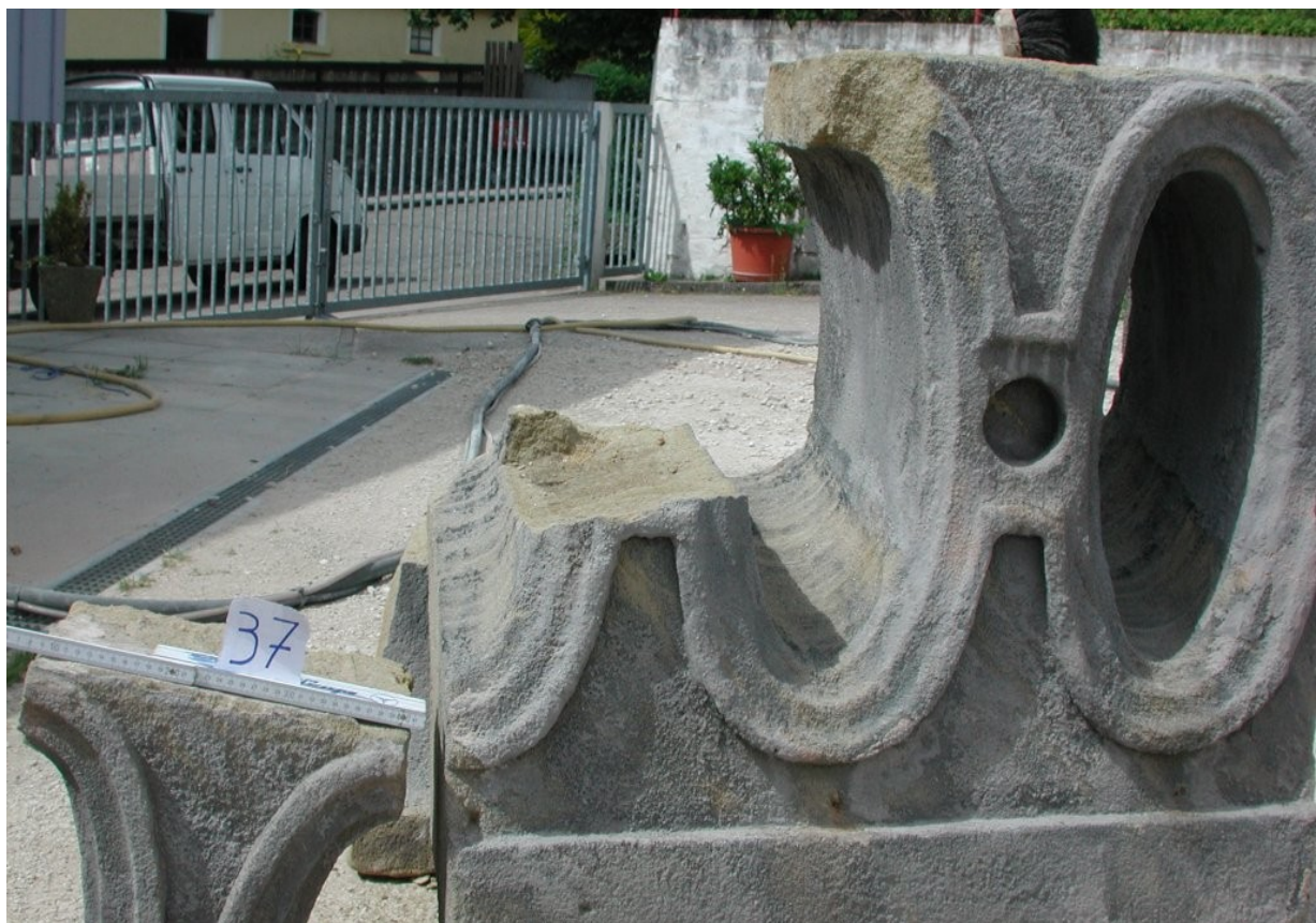
Abb. 8: Verdübeln, versetzen von Bruchstücken
