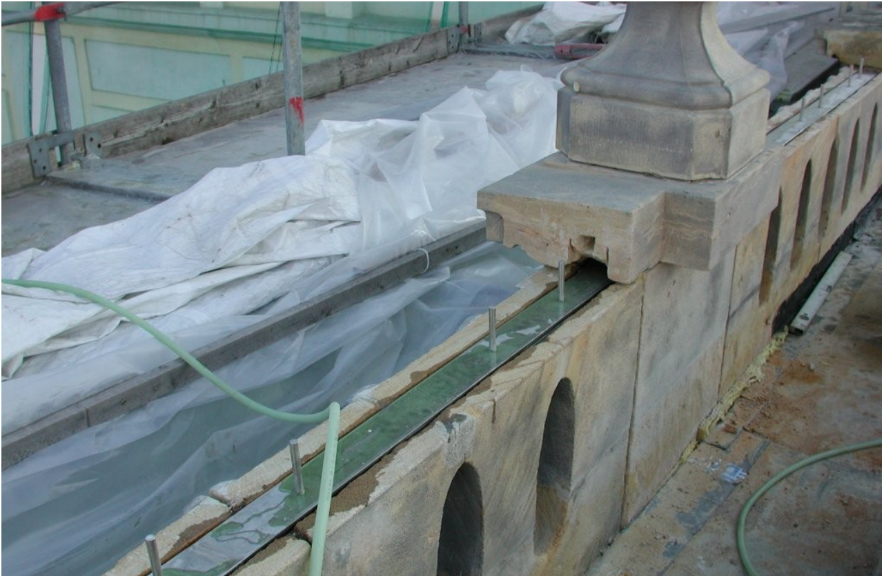
Abb. 11: Neuversetzung der Balustrade
