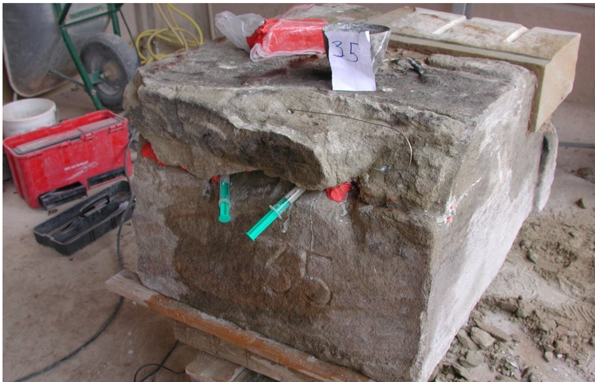
Abb. 6: Versetzen und ausarbeiten einer Vierung, Armieren einer Antragung, Rissinjektion eines Postaments (Position 35)
