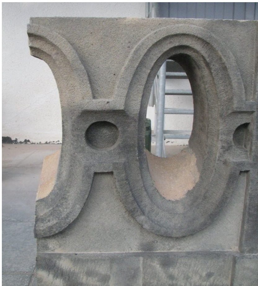
Abb. 10: Entfernung von Gummilippen, Sandstrahlreinigung mit Granatsand als Zuschlag
